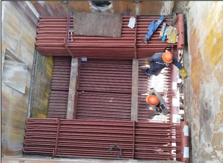
Заменены 32 испарительных пакета на котле-утилизаторе П-402/1 предназначенного для выработки пара 12 кгс/см<sup>2</sup>, блок утилизации дымовых газов с печей С-001, 100 ПГПН
